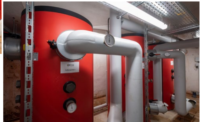
La nuova centrale di riscaldamento è costituita da una caldaia a condensazione a gas UltraGas®, tre pompe di calore Thermalia® e un impianto di cogenerazione (CHP).
