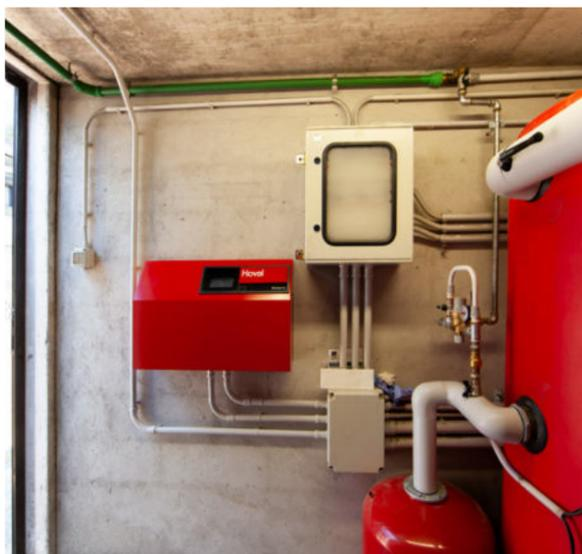
Il nuovo impianto ibrido Hoval è costituito da una pompa di calore Belaria dual AR (60) e da una caldaia a gas a condensazione Hoval UltraGas 100
