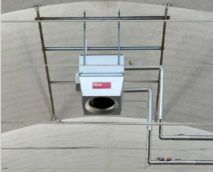
integrazione. Fondamentale è anche il contributo del bruciatore modulante UltraClean, predisposto per adattare in modo continuo la potenza al fabbisogno di calore necessario con emissioni inquinanti minime.
