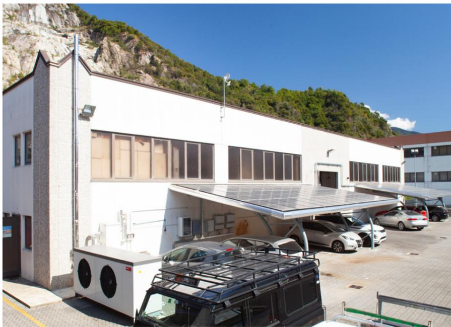
Sulla copertura della pensilina dedicata al Service è stato installato un impianto fotovoltaico, collegato a una colonnina di ricarica per auto elettriche e a servizio della pompa di calore
