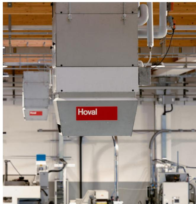
perficie produttiva totale 3400mq di cui climatizzato Hoval 2600mq, altezza max capannone 8,80m si è infatti deciso di installare 9 unità Hoval Top Vent TC, complete di sistema di regolazione Top Tronic C e quadro elettrico.
