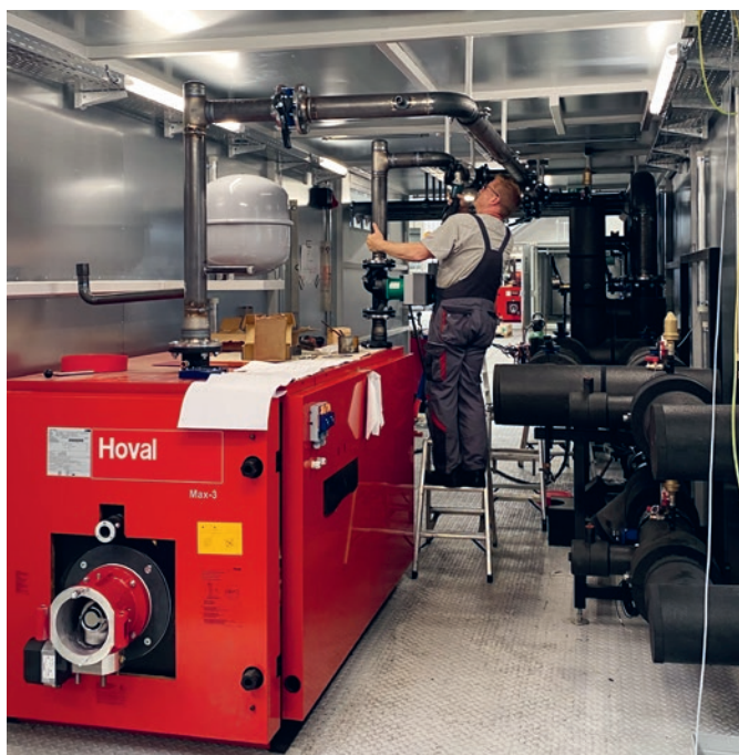
Lavori di montaggio di una centrale di energia.
