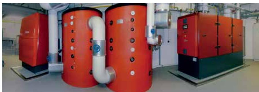
Tecnologia avanzata per il Centro Veicoli Industriali Mercedes-Benz di Francoforte: centrale termica con impianto di cogenerazione PowerBloc, caldaia a condensazione a gas UltraGas<sup>®</sup>, accumuli termici e altri componenti di sistema.
