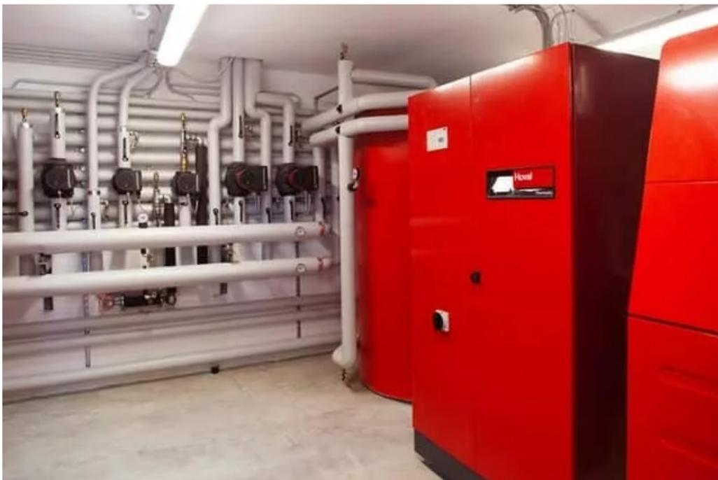
Grazie a questa soluzione è possibile soddisfare il fabbisogno dell'edificio garantendo la **climatizzazione sia invernale che estiva**; inoltre, gli **scambiatori di calore ad ampia superficie** in acciaio inox ottimizzano il trasferimento di calore all'acqua di riscaldamento per raggiungere elevate temperature e un eccellente rendimento.
