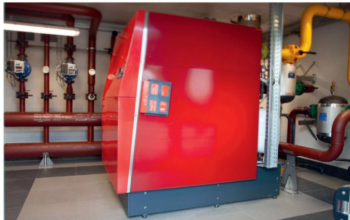
**FONDAMENTALE** è risultata la riqualificazione della centrale termica con la caldaia a condensazione UltraGas 1150 kW, che ricava dal 10% al 20% in più di energia, con un rendimento pari a oltre il 109%
