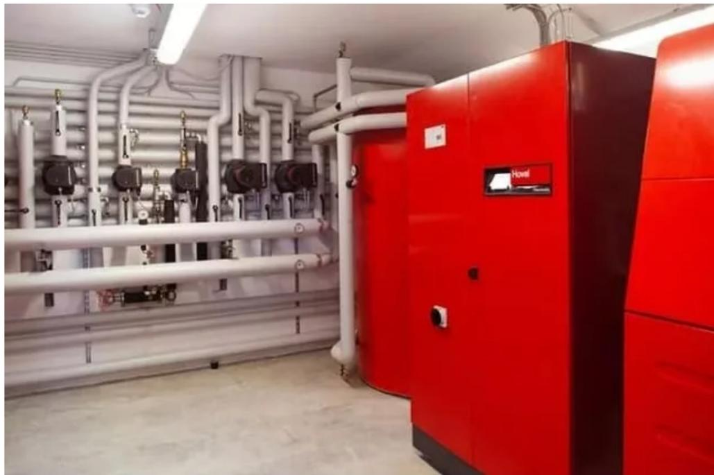
*La pompa di calore **Hoval Thermalia** estrae l'energia dal suolo e la trasforma in energia per il riscaldamento, il raffrescamento e la copertura del fabbisogno di acqua calda. Per ottimizzare il rendimento si può combinare con i collettori solari.*
