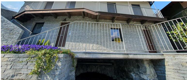
"Casa Giaglione" è caratterizzata da generose balconate in legno collegate da tiranti in acciaio inox, con funzione strutturale per il loro sostegno, a ricordare i "gafi" tipici delle abitazioni di montagna e ampie superfici vetrate della mansarda, arretrate rispetto al filo facciata.
