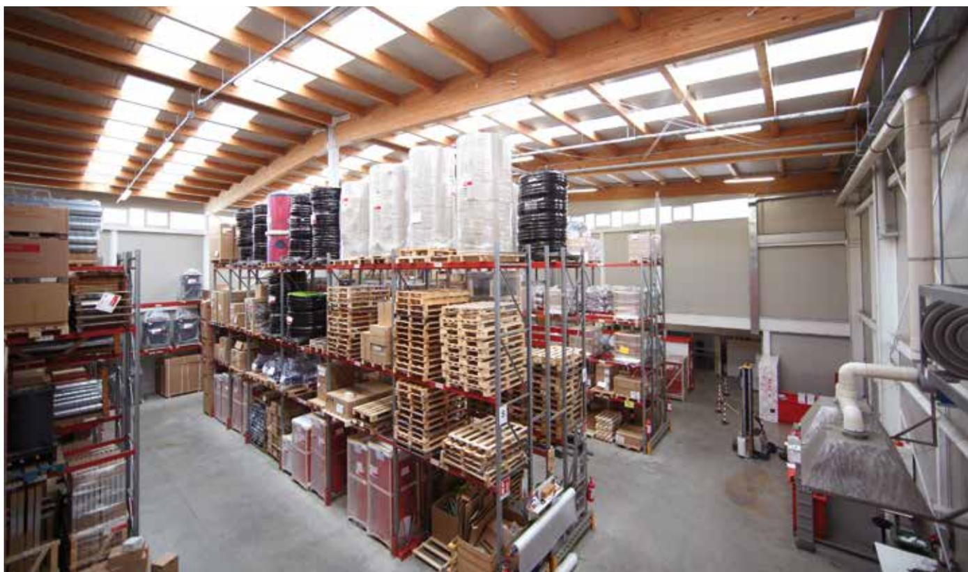
Il magazzino di Casa Hoval è una struttura in metallo e legno: l'involucro esterno è realizzato con pannelli sandwich isolati in modo da creare un clima ambientale gradevole, mentre l'illuminazione naturale dello spazio è stata ridotta al minimo richiesto dalla normativa per evitare il surriscaldamento durante l'estate.
