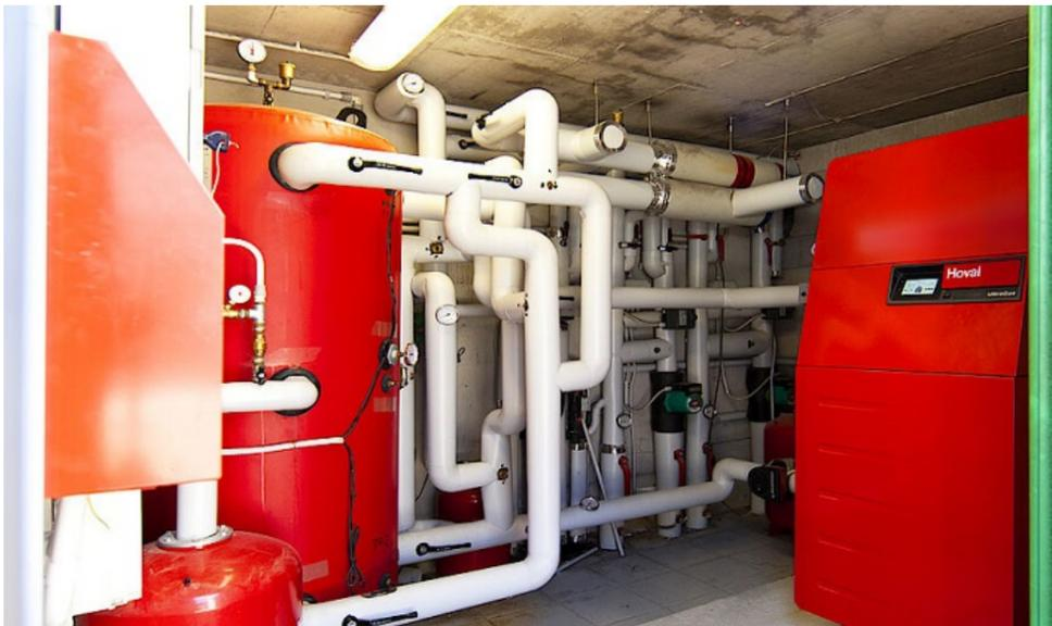
Per la produzione di energia sono stati installati **66 pannelli Soland** che sviluppano una potenza massima totale di 25,56 kw, mentre per la sostituzione del vecchio generatore di calore, che risultava avere una potenza sovradimensionata rispetto al reale fabbisogno dell'edificio, è stata scelta una soluzione ibrida Hoval, costituita da:
