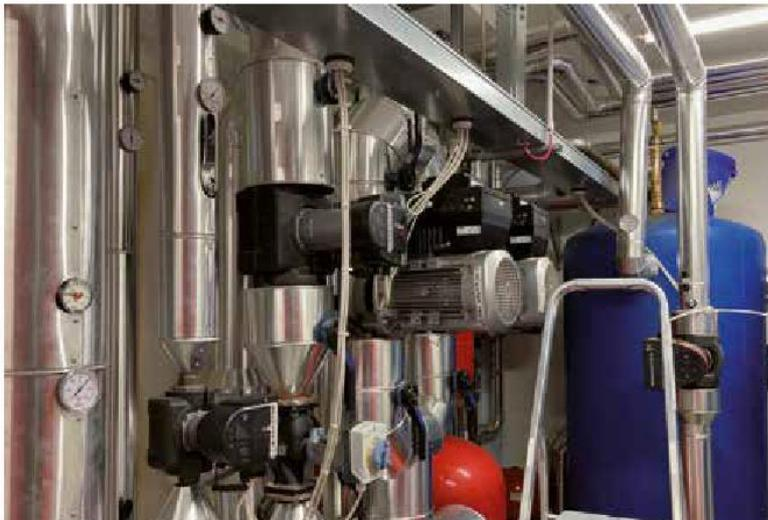
La massima efficienza del sistema è garantita dalla presenza del dispositivo di regolazione Hoval Digital che gestisce i generatori e tutti i circuiti a servizio della struttura.
