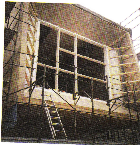
In basso, la struttura in legno e acciaio della Sala Climatica.
